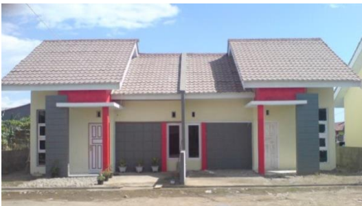
Gambar 5. Bangunan gandeng dua tidak bertingkat
